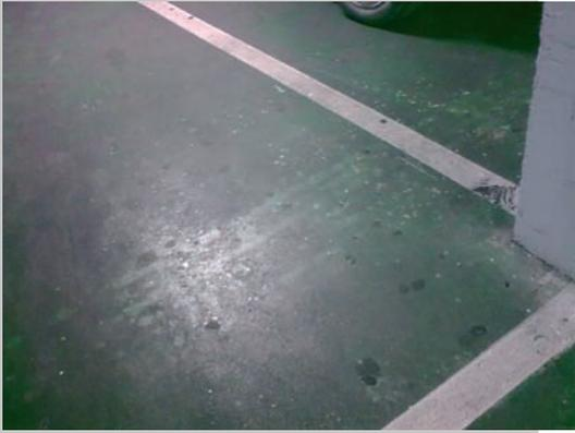
Superficie de hormigón con desgaste y desperfectos debido al uso
